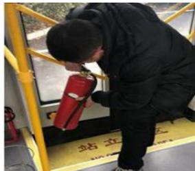
及开福寺场站内的充电桩、消防设施、电器设备等进行检查,特别是针对灭火器,逐一打开灭火器箱,仔细查看有效期和完好率,认真检查灭火器压力大小、有无锈
